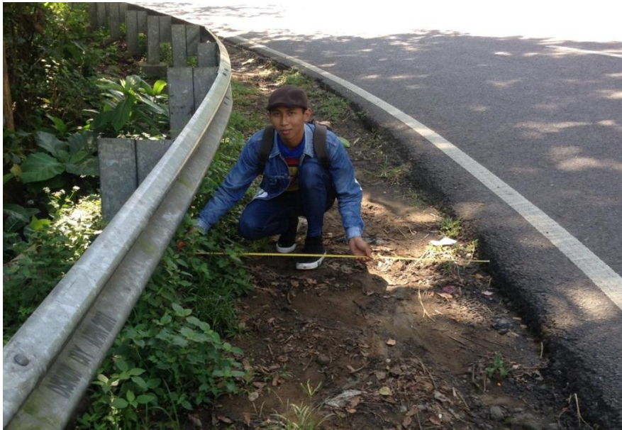
Gambar 4.5. Pengambilan data luas bahu jalan
