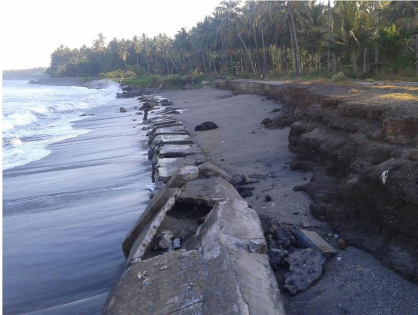
Gambar 1.3 Bangunan Seawall setelah terjadi kerusakan
