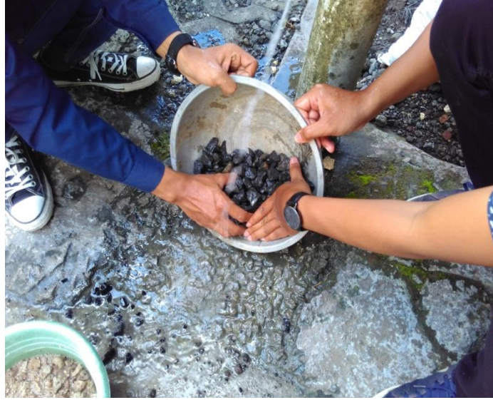
Gambar 20. Pencucian agregat kasar
