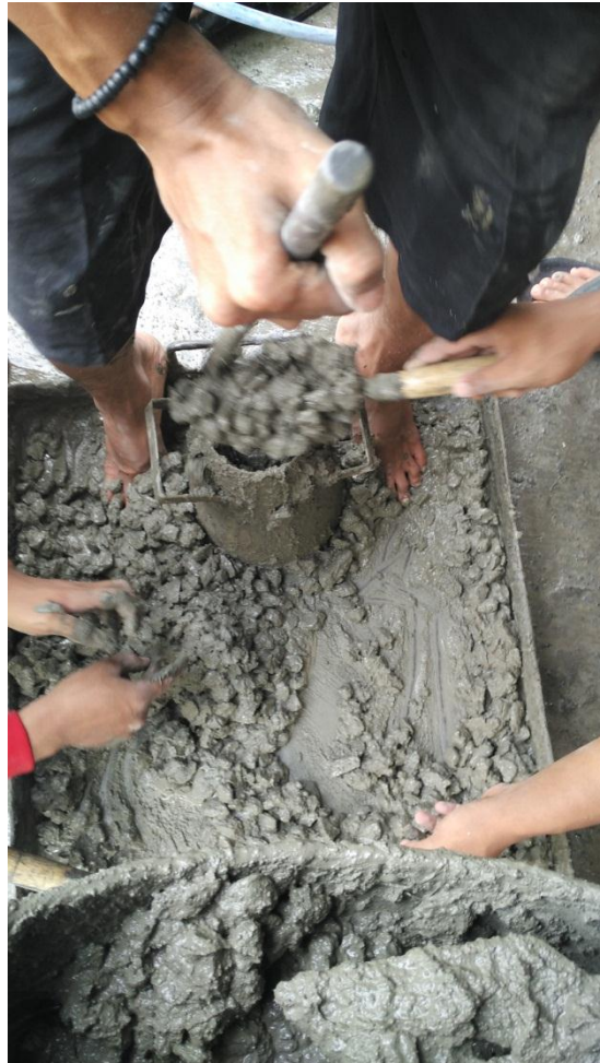
Gambar 27. Pematatan beton segar kedalam silinder/cetakan
