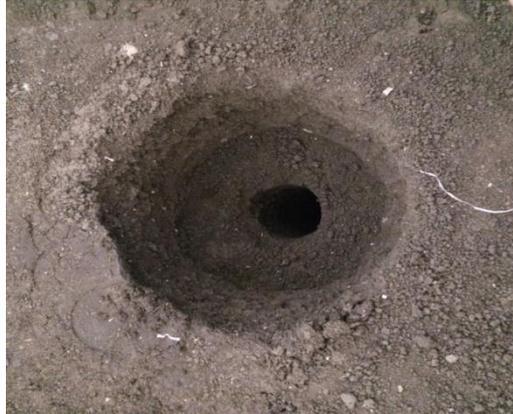
Gambar 3.14 Hasil Pengeboran kolom *T-shape* 70 cm
