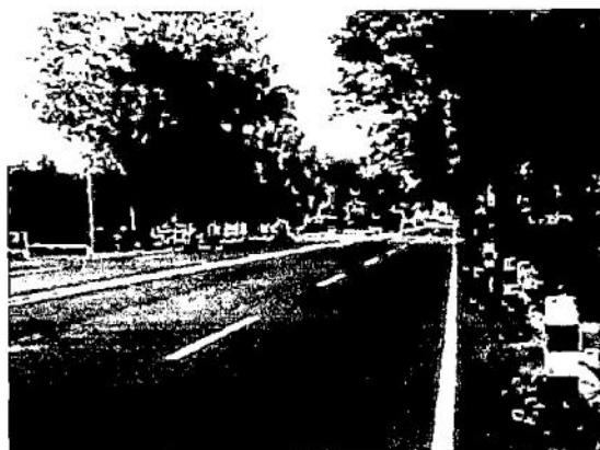
Gambar 7. Jalan Magelang Km 12
