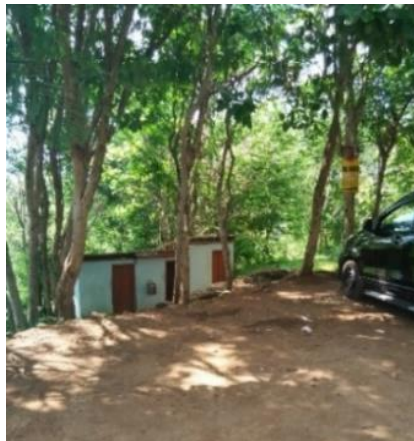
Gambar 12. Kondisi Eksisting Toilet Umum di Kebun Buah Mangunan
