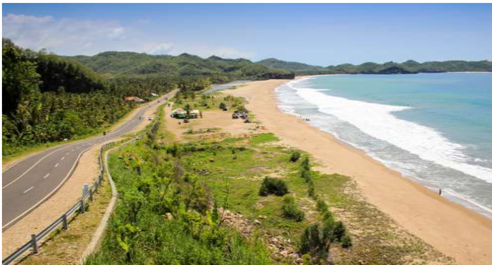
Gambar 20. Kondisi fisik Pantai Soge
