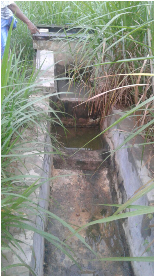
Bak pembagi menuju jaringan beton
