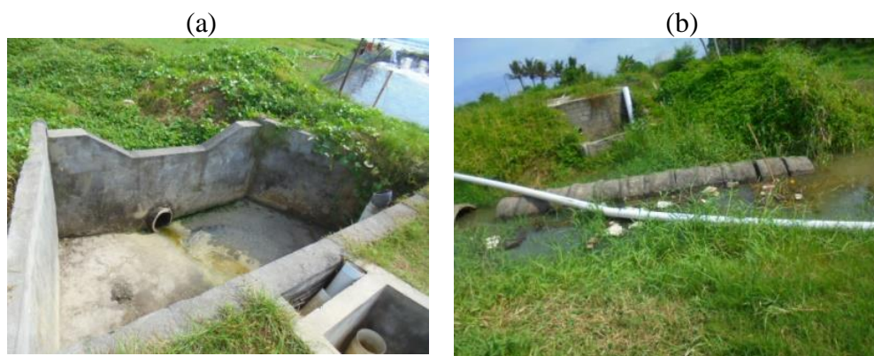
(a) bak penampung limbah cair sebelum dibuang (b) gorong-gorong saluran pembuangan limbah
