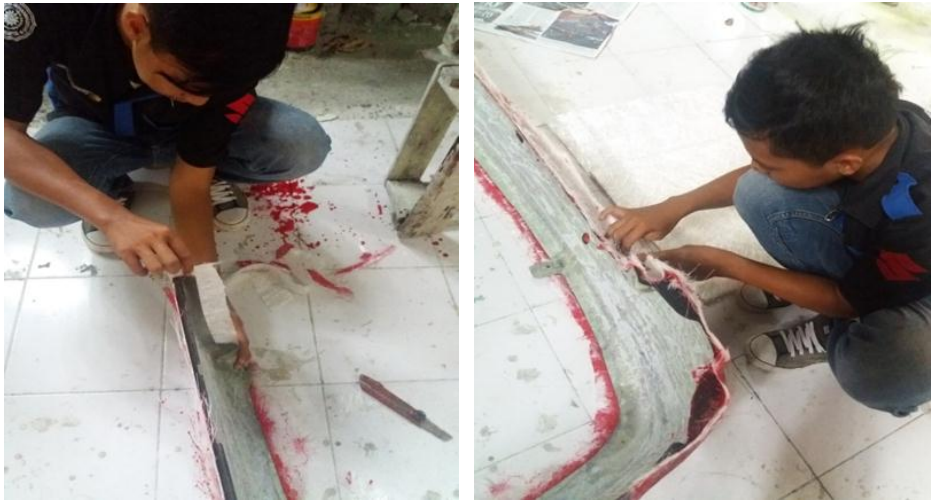
Gambar 4.26. Pencetakan dan pemasangan mat pada bagian lekukan.
