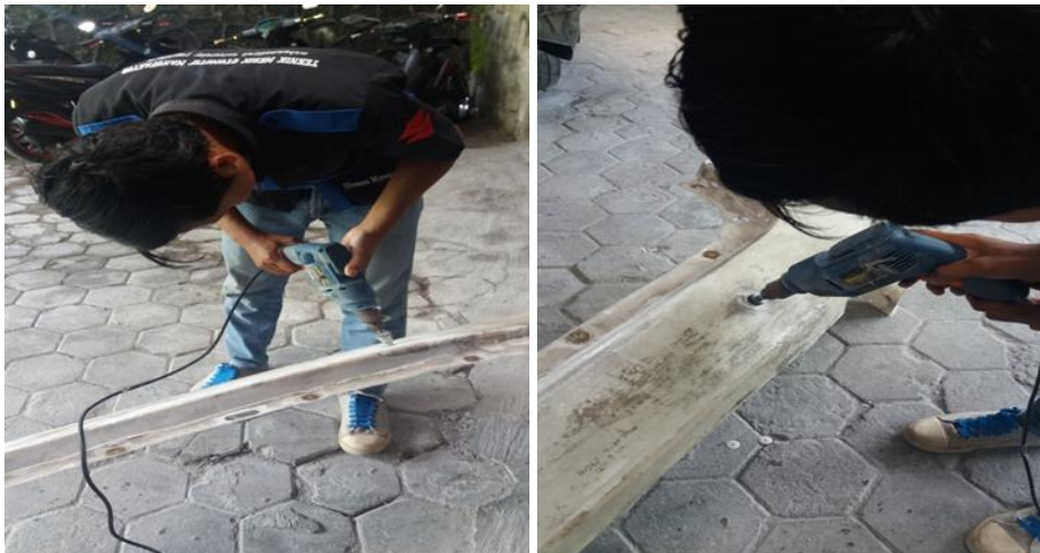
Gambar 4.17. Pengemboran lubang baut dan sensor parkir.
