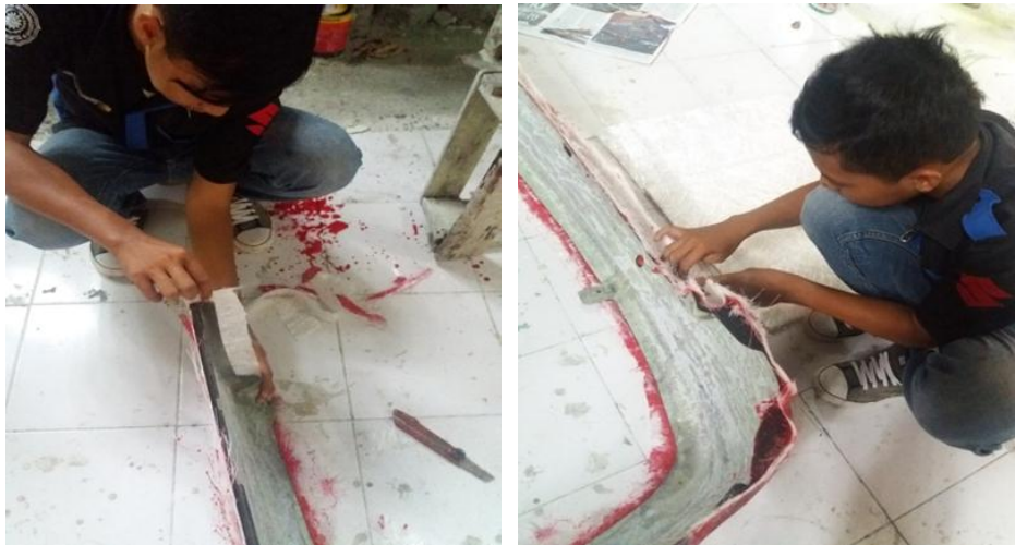
Gambar 4.26. Pencetakan dan pemasangan mat pada bagian lekukan.
