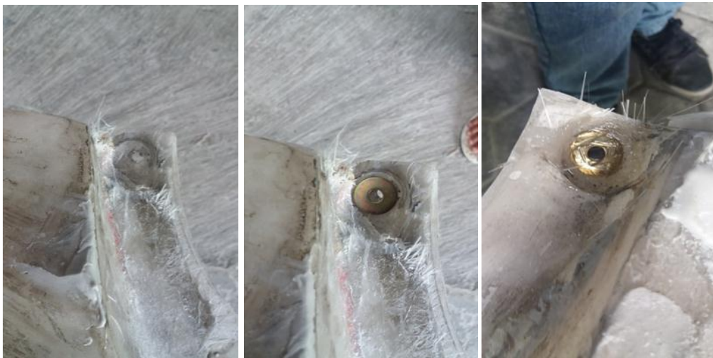
Gambar 4.19. Pelapisan ring dan fiberglass pada bagian dudukan baut.
