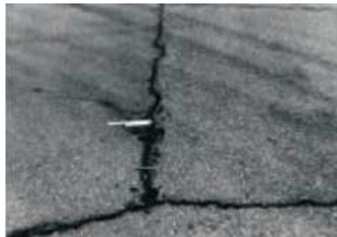
**Gambar 3.17** Retak Sambung (*Joint Reflec Cracking*)
