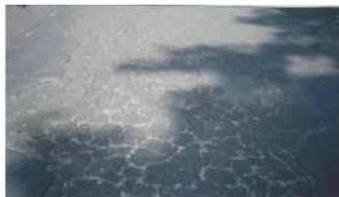
**Gambar 3.39** Pelepasan Butir (*Weathering/Raveling*).
