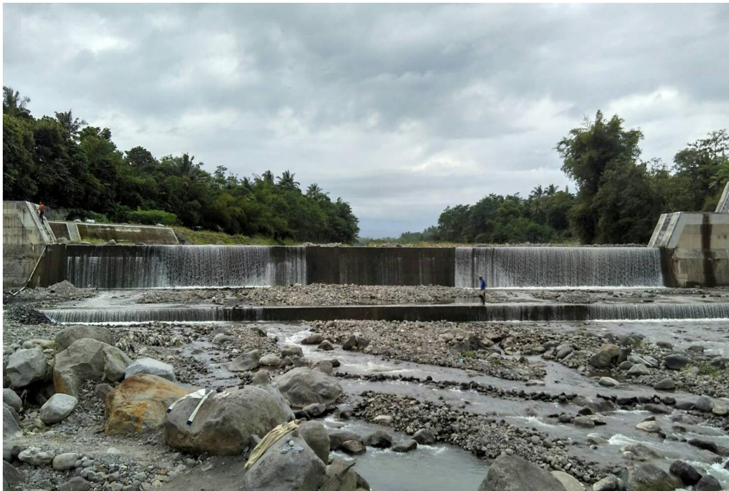
Tampak Sabo Dam Dari Hilir
