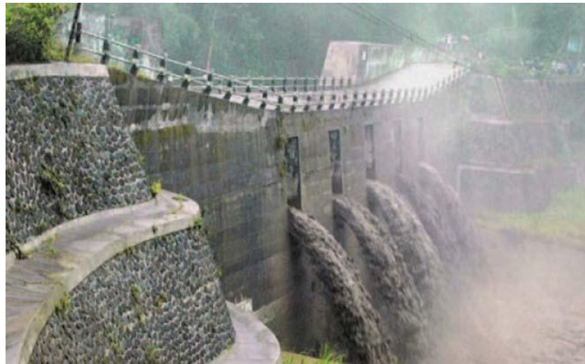
Gambar 2.3 Sabo Dam Tipe Terbuka ( Slit )
