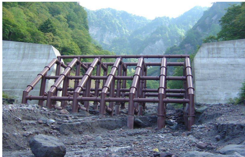
Gambar 2.4 Sabo Dam Tipe Terbuka ( Grid )
