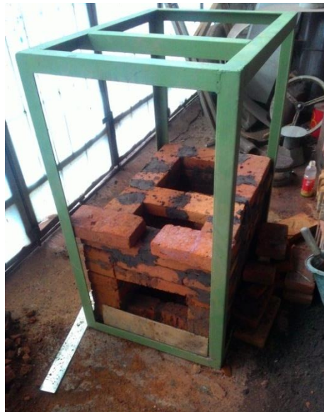
Gambar 4.8 Pembuatan ruang chamber incinerator
