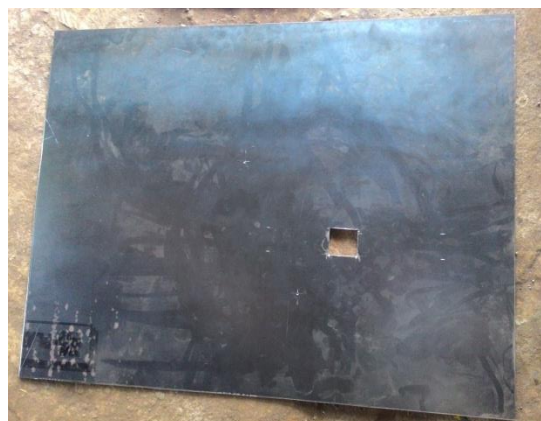
Gambar 4.15 Hasil pembuatan casing samping incinerator
