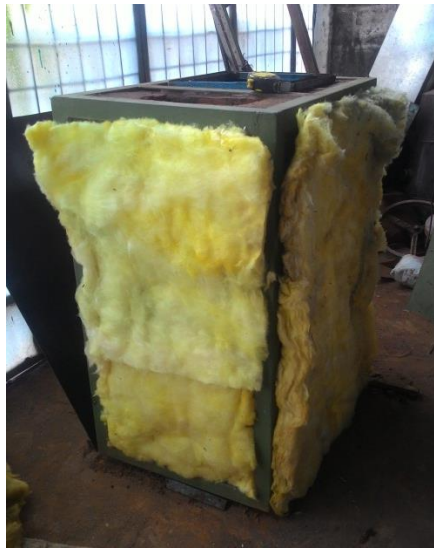
Gambar 4.18 Pemasangan glass wool pada incinerator
