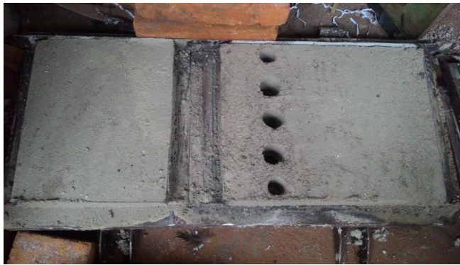
Gambar 4.24 Hasil pengecoran castable pada pintu
