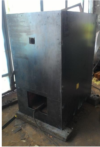
Gambar 4.19 Hasil Pemasangan casing incinerator
