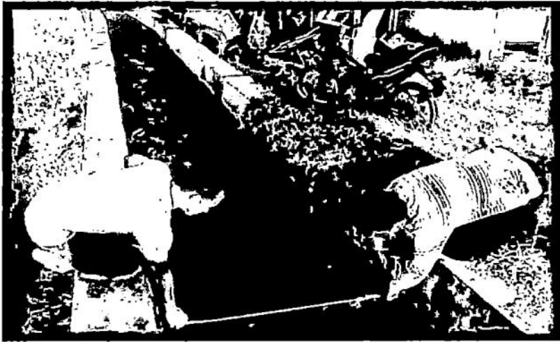
Gambar 4.5 Pengambilan Lebar Saluran Air
