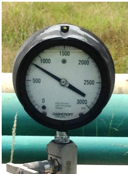
Gambar 3.5. Pressure gauge setelah melewati control valve
