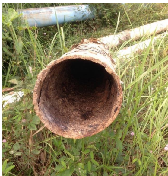
Gambar 4.10. Kondisi bagian dalam pipa injeksi 6 in
