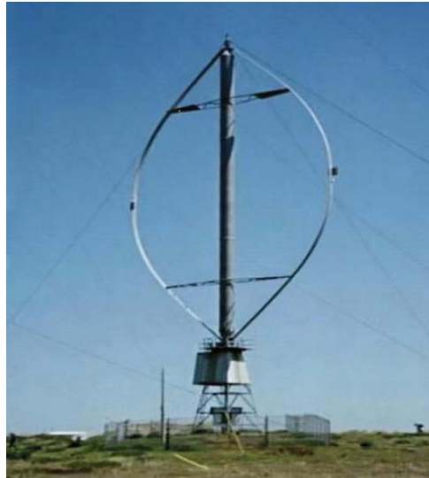
Gambar 2.3. Kincir angin VAWT tipe Darrieus Sumber: http://www.getsttpln.com/2014 .
