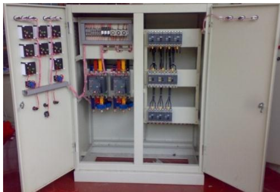
Gambar 2.7. Panel Utama Tegangan Rendah (sumber: http://sentradayaabadi01.blogspot.com/ )
