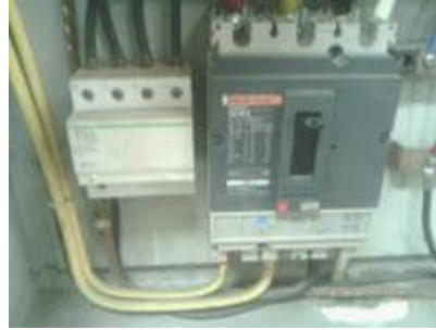
Gambar 2.23 Contoh instalasi arrester pada jaringan kelistrikan
