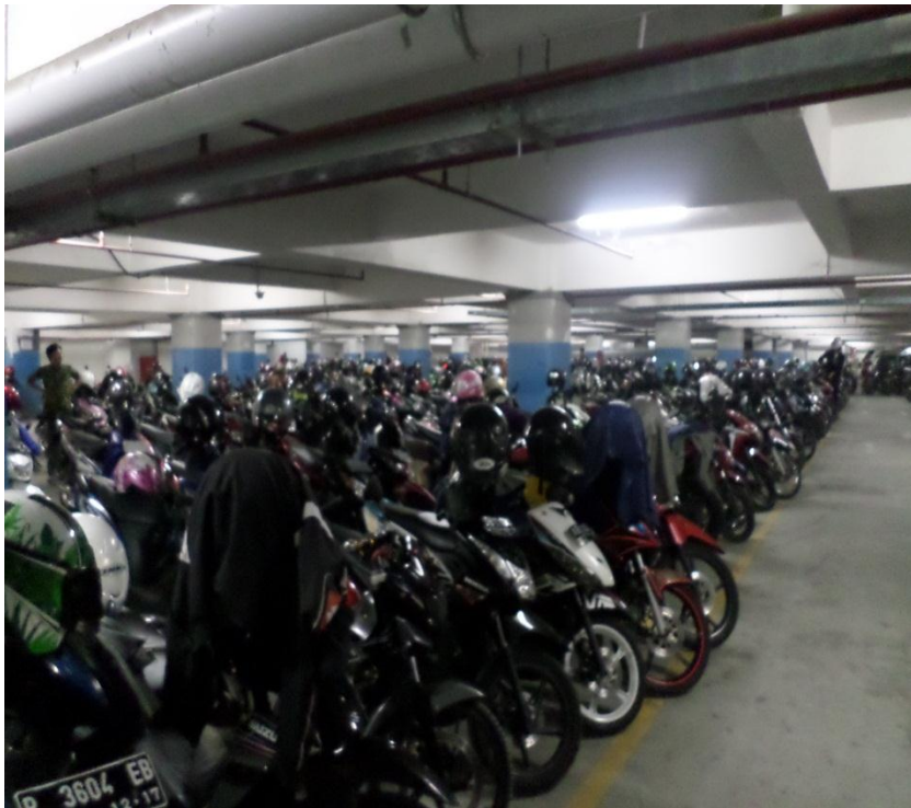
AREA PARKIR KHUSUS PENGUNJUNG KENDARAAN RODA 2 (DUA) RUANG LANTAI BASEMENT P1 DENGAN POSISI PARKIR SUDUT 90 0
