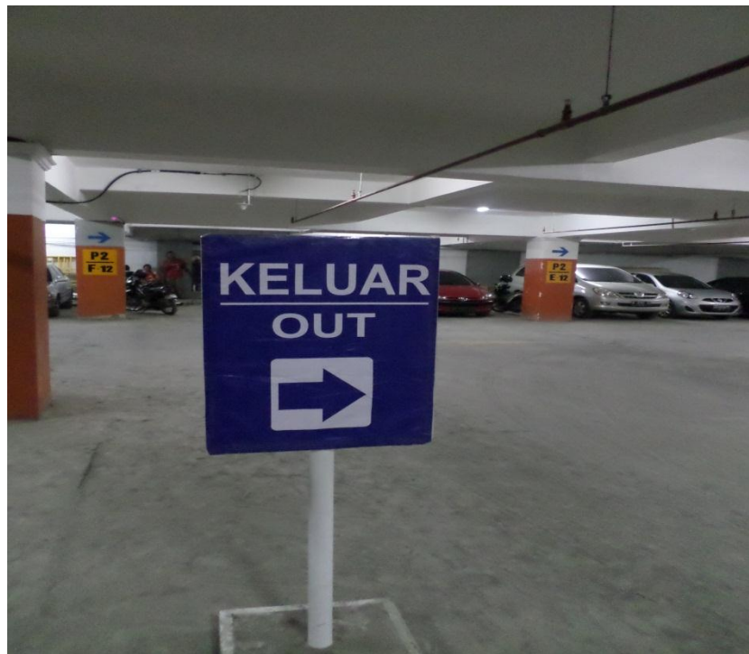
RAMBU PETUNJUK DI AREA PARKIR LANTAI BASEMENT P2 KHUSUS KENDARAAN RODA 4 (EMPAT)
