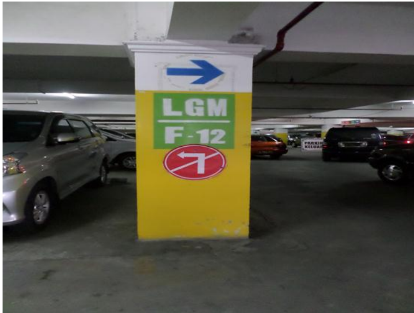
RAMBU PETUNJUK DI AREA PARKIR LANTAI BASEMENT LGM KHUSUS KENDARAAN RODA 4 (EMPAT)
