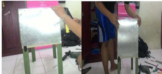
Gambar 3.18 Pemasangan Cover Alat Uji
