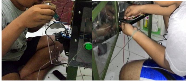
Gambar 3.20 Proses Pemasangan Komponen dan Rangkaian Listrik
