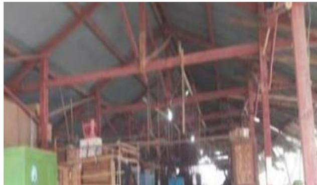
Kondisi atap sebelum revitalisasi dapat dilihat pada gambar di atas. Penopang atap terbuat dari kayu dan atapnya terbuat dari asbes. Atapnya juga masih pendek tidak setara dengan atap bagian kios atau gedung bagian depan. Dalam hal ini atap dapat dikatakan belum dibangun secara permanen.
