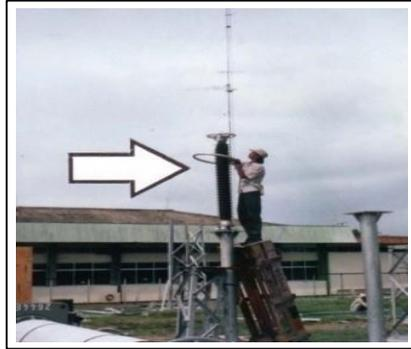
Gambar 2.7. *Lightning Arrester (LA)*.
