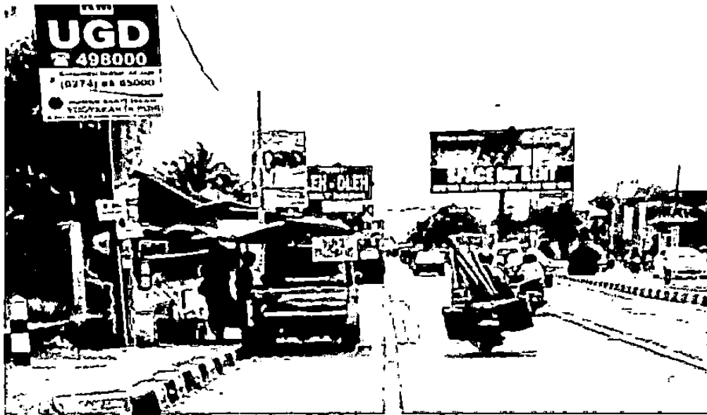
Gambar 5.14 Bahu jalan yang digunakan untuk keperluan berdagang
