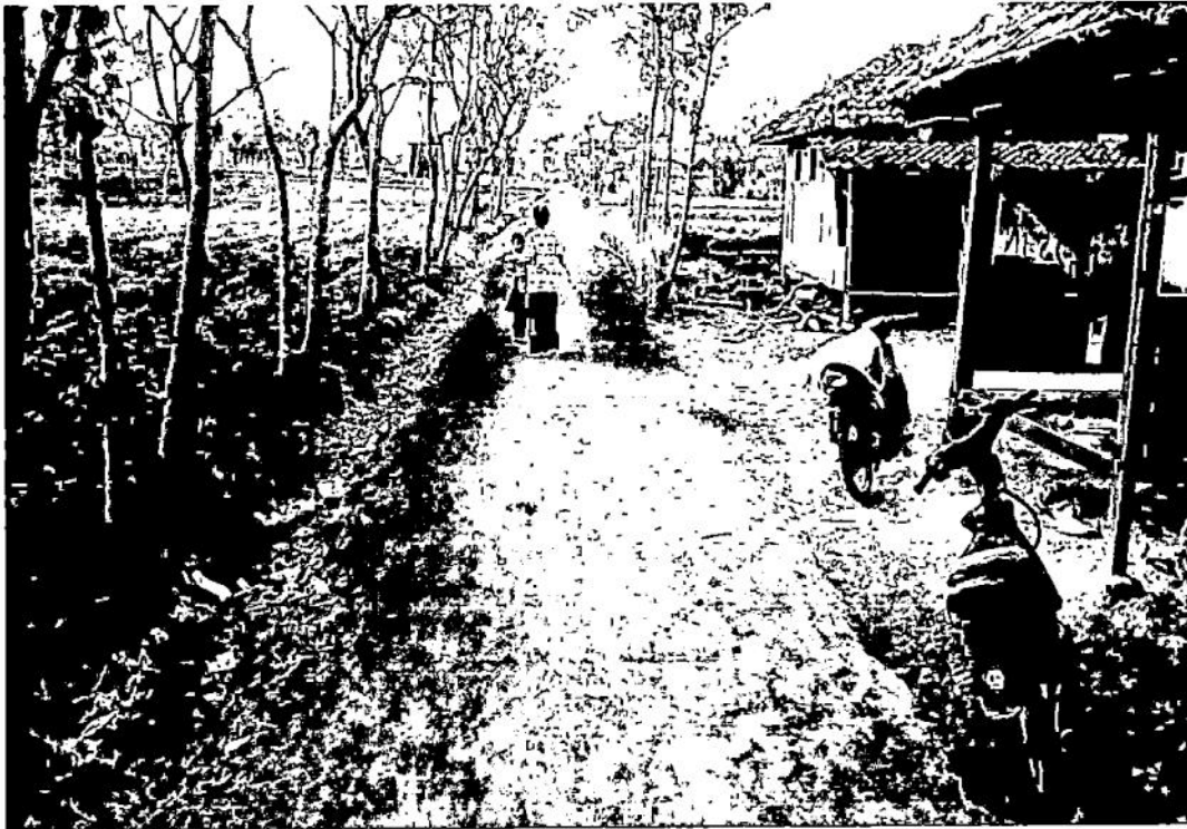
Gambar 3.5 Kondisi Pengaspalan Jalan
