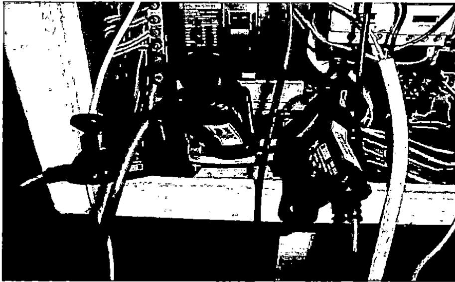
Gambar 3.1.d. Cara pemasangan MN93 pada panel listrik Lab
