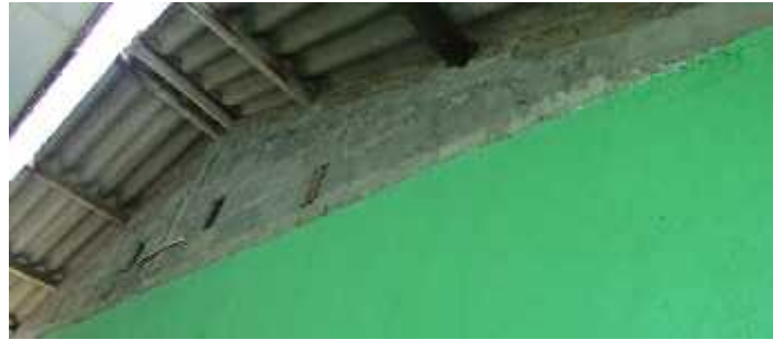
Gambar 9. Bingkai ampig beton bertulang
