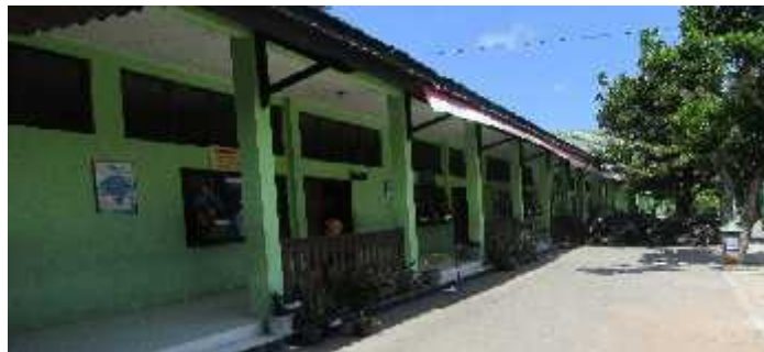
Gambar 10. Bangunan yang terlalu panjang.
