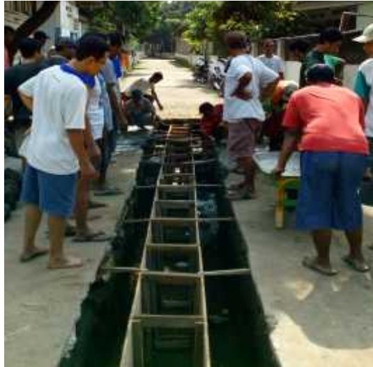
Gambar 2.5. Pengisian dinding saluran dengan pasangan batu kali 1:4
