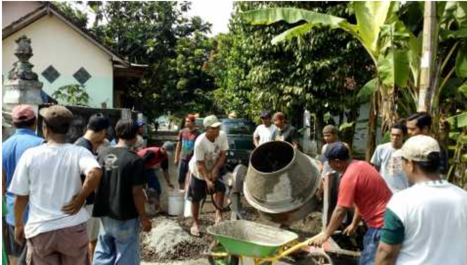
Gambar 2.7. Pengadukan menggunakan alat molen.
