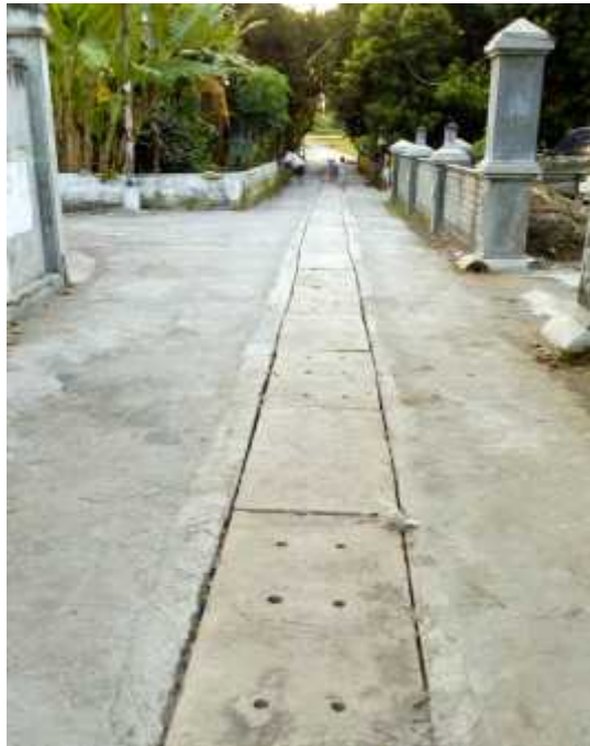
Gambar 2.9. Tutup saluran sudah mengeras.
