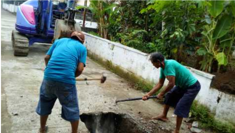
Gambar 2.3. Penggunaan Small Backhoe dalam pembuatan lubang drainase.
