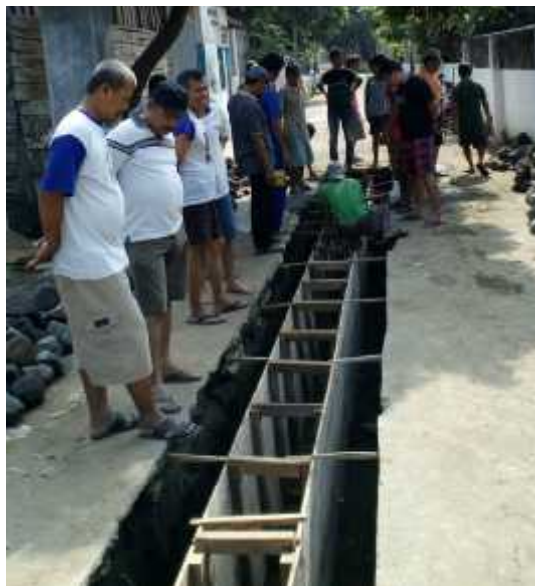
Gambar 2.4. Begisting pada saluran drainase
