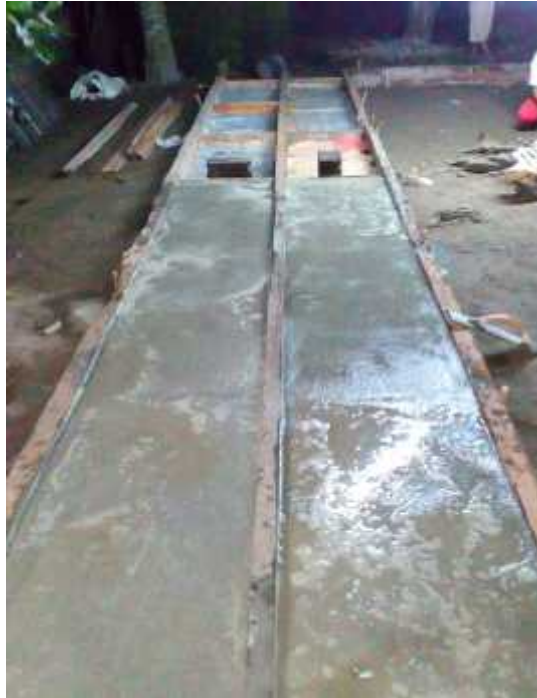
Gambar 2.8. Tutup saluran yang sudah selesai di cor
