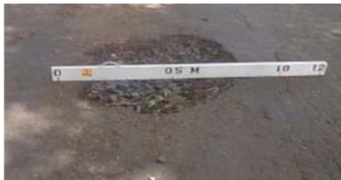
Gambar 3. 27. Lubang ( Pothole )
