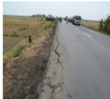
Gambar 3. 15. Retak Samping Jalan ( Edge Cracking ) Sumber : Bina marga no.03/MN/B/1983
