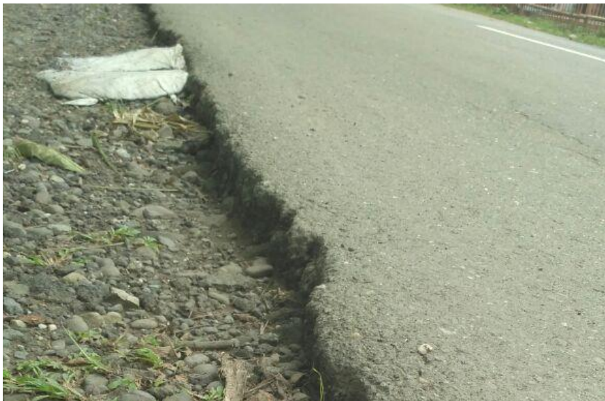
Gambar 7 Pinggir Jalan Turun Vertikal
