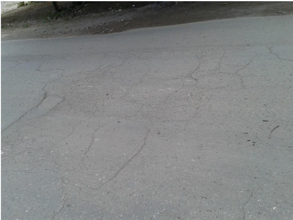
Gambar 3 Retak Kotak-Kotak
