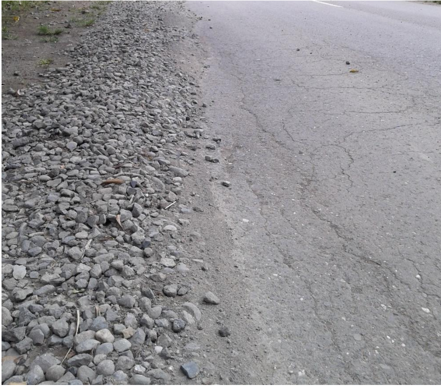
Gambar 5 Retak Pinggir
