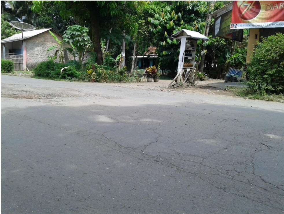
Gambar 8 Retak Memanjang
