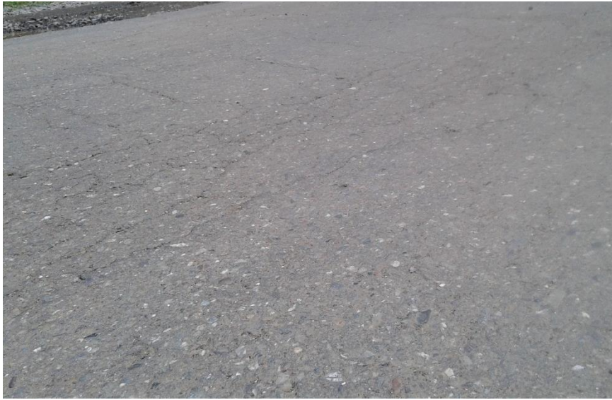
Gambar 10 Pengausan Agregat
