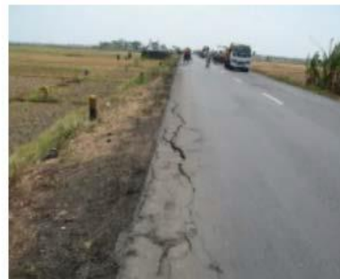
Gambar 3.14 Retak Samping Jalan ( Edge Cracking ) Sumber : Bina Marga No.03/MN/B/1983
