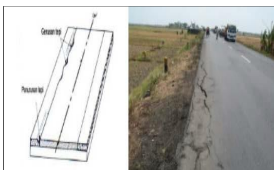
Gambar 3.14 Retak Samping Jalan ( Edge Cracking )
