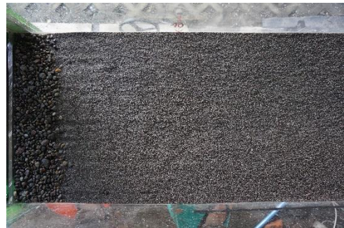
Peredam Energi di Hulu saluran
