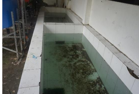
Bak penampung air
