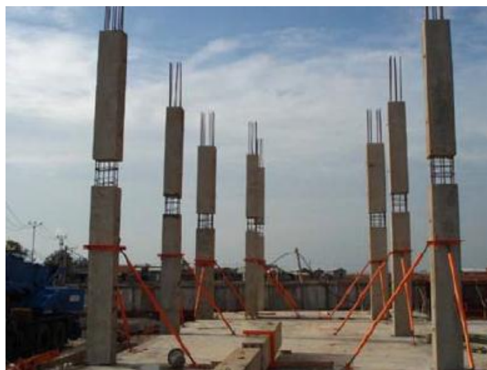
Gambar 3.3 Sistem sambungan KML (Puslitbang, 2010)
