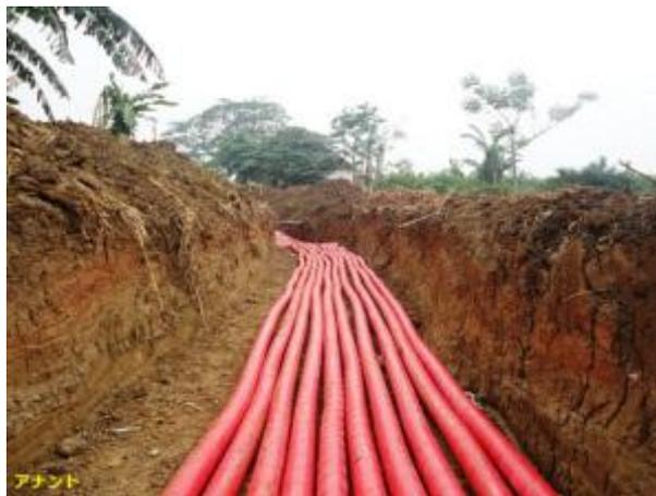
Gambar 2.2 Saluran Kabel Tegangan Menengah (SKTM)
