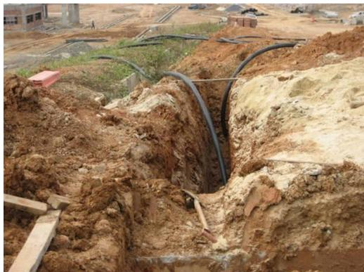
Gambar 2.4 Saluran Kabel Tegangan Rendah (SKTR)
