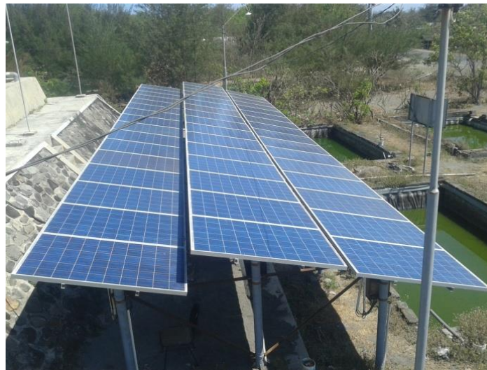
Gambar 4.1. Panel Surya Pada PLTS Sistem 48V
