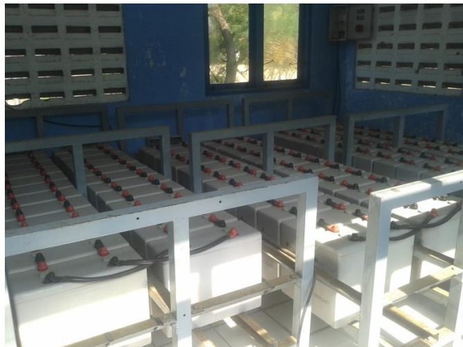
Gambar 4.2. Baterai Yang Digunakan Pada PLTS Sistem 48 V
