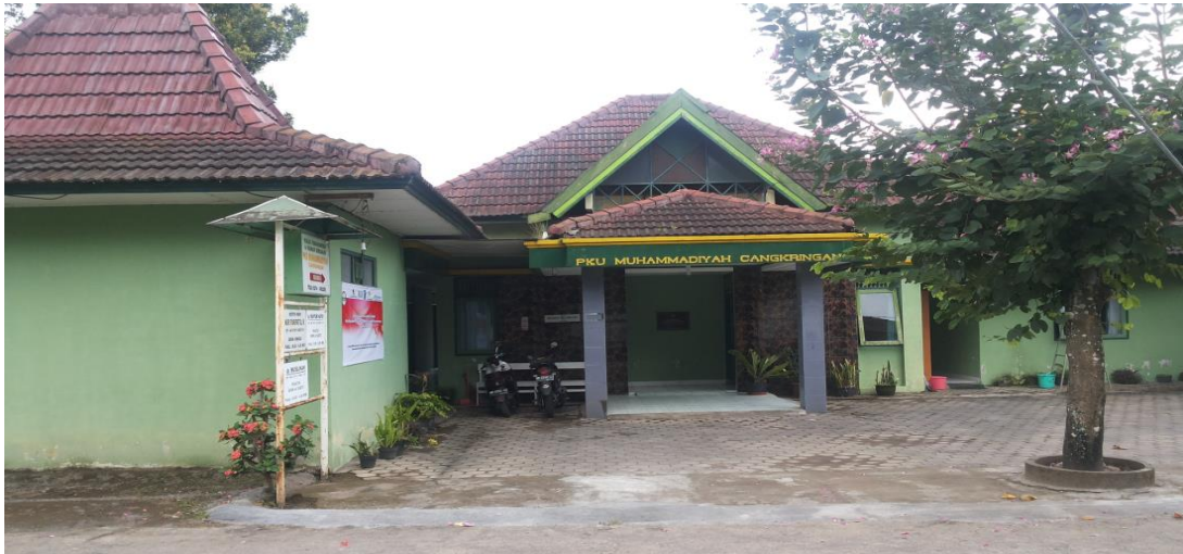
Gambar 8.1 Gedung Klinik Pratama PKU Muhammadiyah Cangkringan
