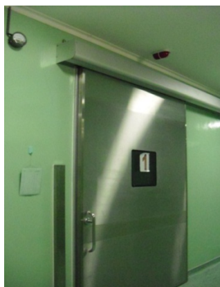
Gambar 4.17 Pintu Masuk Ruang Operasi
