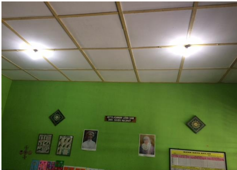
Gambar 1.4. akibat bangunan di sebelah ruang kelas menjadi gelap sehingga di siang hari terpaksa harus menyalakan lampu
