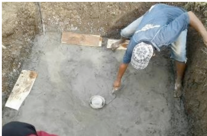
Gambar 2.13. Pekerjaan acian untuk lantai kolam.
