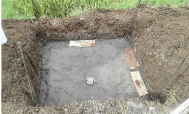
Gambar 3.3. Hasil akhir pekerjaan pondasi, sloof, dan lantai kolam.
