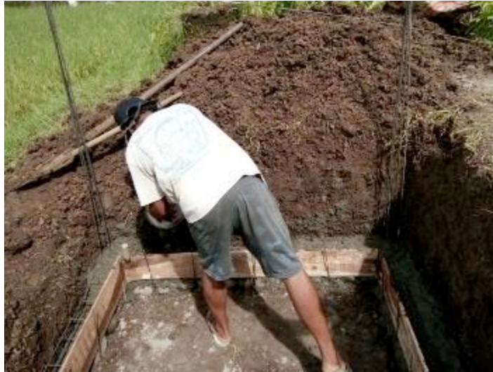
Gambar 2.11. Pengecoran sloof.
