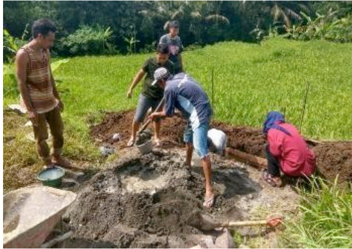
Gambar 2.8. Pengadukan beton secara manual.
