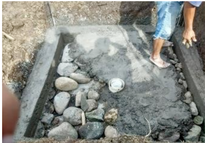
Gambar 2.12. Pengecoran lantai kolam.
