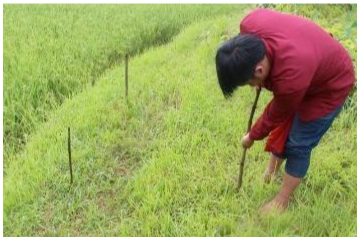
Gambar 2.4. Survey lapangan dan pemasangan patok.
