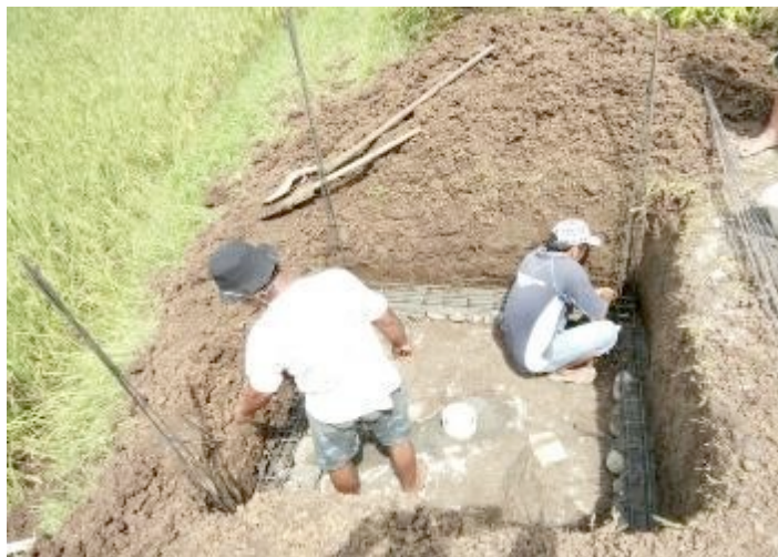
Gambar 2.10. Instal besi sloof dan kolom.
