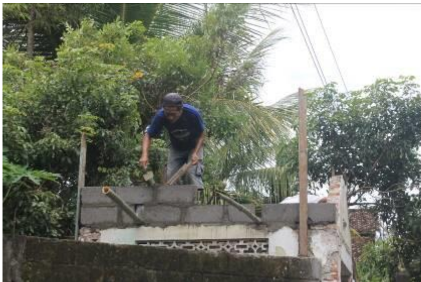
Gambar 4. Pemasangan dinding poskamling.
