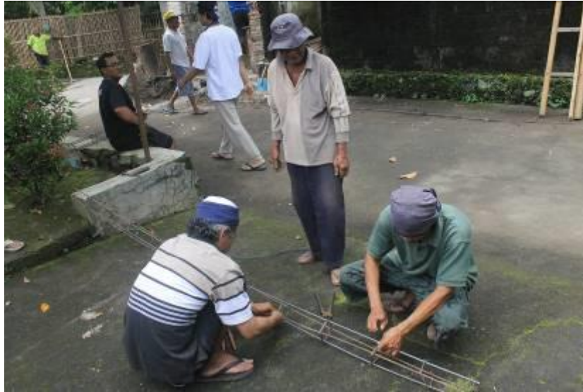
Gambar 3. Perakitan besi tulangan.
