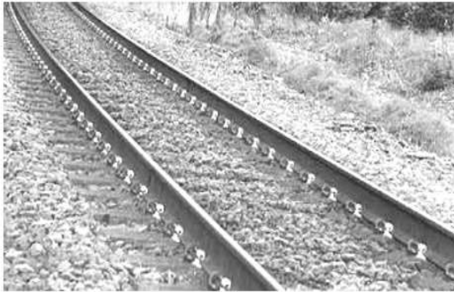
Gambar 3.1 Konstruksi jalan rel (Sumber : Rosyidi, 2015)
