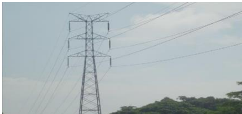
Gambar 2.8. SUTT dengan dua kawat tanah
