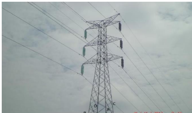
Gambar 2.21. Nama kaki tower SUTT 150 KV
