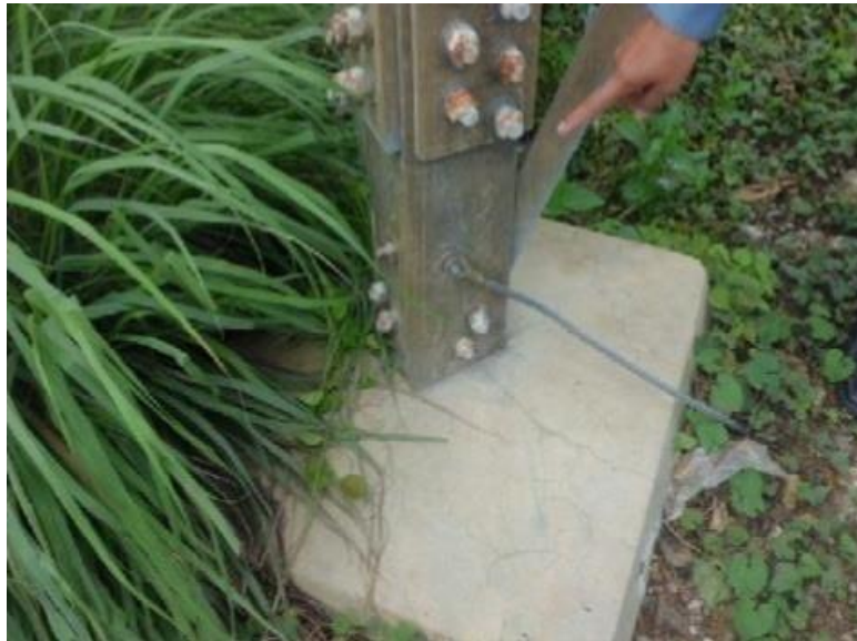
Sambungan Arde dengan Kaki Tower SUTT 150 KV
