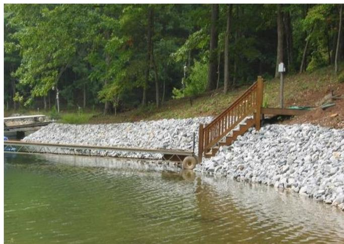
Gambar 3.3 Contoh riprap sebagai *revetment*
