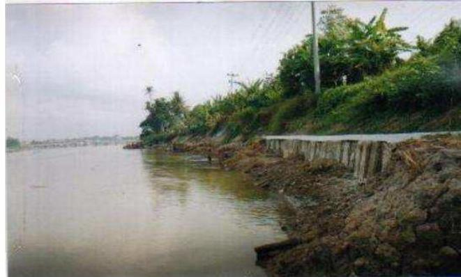
Gambar 3.8 Contoh dinding penahan dari beton
