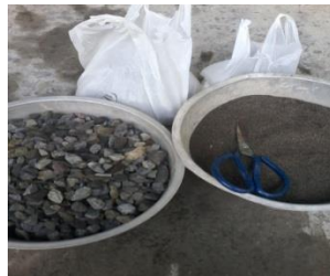
Gambar 4.23 Bahan pembuatan beton dalam 1 adukan
