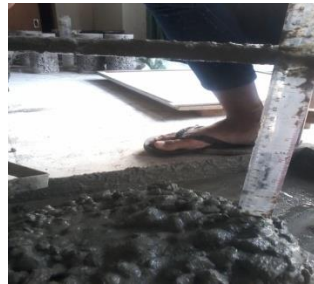
(a) Pengujian slump
