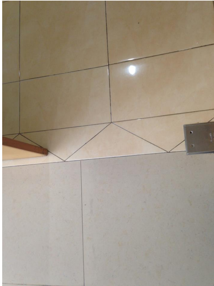
Gambar 13 Kondisi lantai IGD RS PKU Muhammadiyah Yogyakarta Unit II
