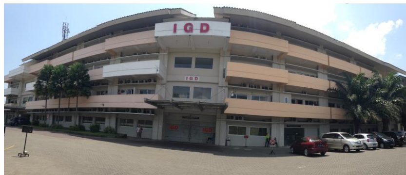
Gambar 3 Tampak Depan Ruang IGD RS PKU Muhammadiyah Yogyakarta Unit II
